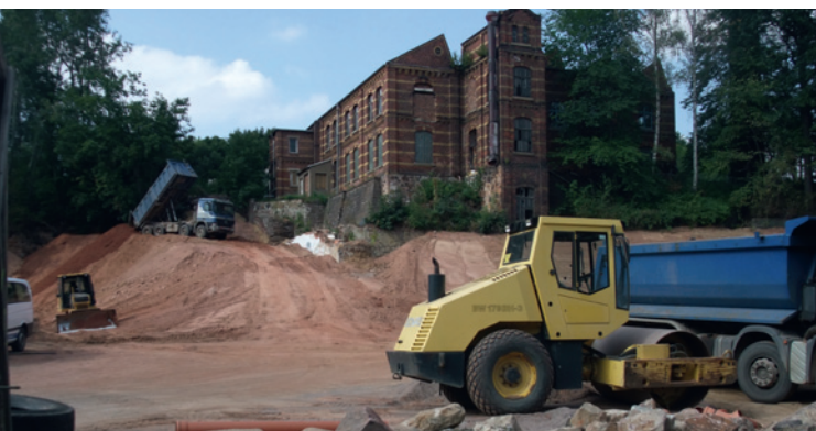
Auf dem Gelände der ehemaligen Kratzenfabrik entsteht demnächst eine Grünfläche
